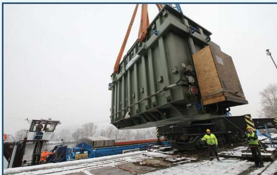
nakládku tří transformátorů v přístavu v Lovosicích. Každý kus o rozměrech 6,10 x 2,90 x 3,58 metru váží 129 700 kilogramů. Vyrobita je firma
